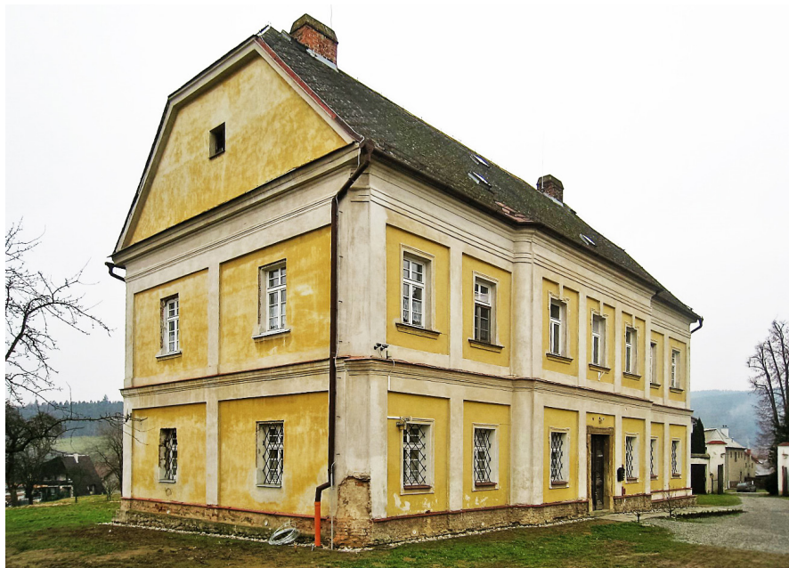
④ Fara před opravou střechy a krovu, 2014. Foto Dobroslava Neckařová.
